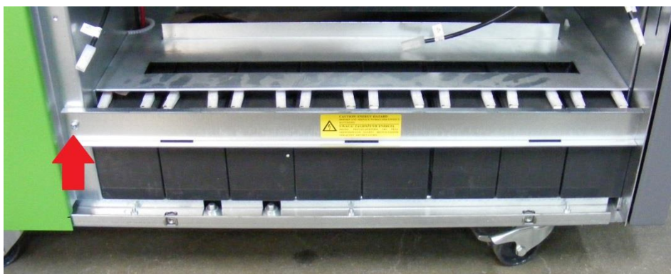
Fot. 9. Montaż blokady akumulatorów
